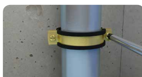
7. Aperte o parafuso da abraçadeira com o binário de aperto recomendado
