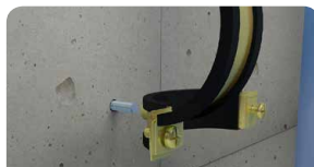
4. Insira a abraçadeira na bucha previamente instalada
