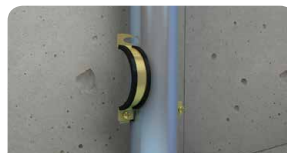
5. Abra a abraçadeira e coloque o tubo
