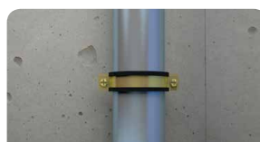
8. Abraçadeira está instalada
