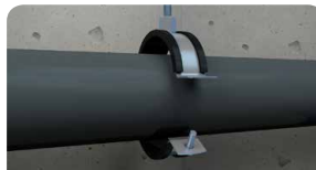
5. Coloque o tubo e aperte a abraçadeira
