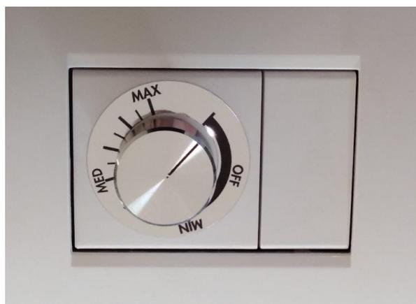
O variador de tensão permite, através da rotação do botão, selecionar a velocidade de funcionamento dos ventiladores permitindo debitar diferentes caudais de ar.
