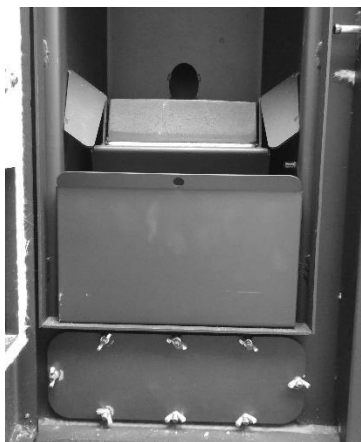
Figura 53 - Limpeza do interior da salamandra
