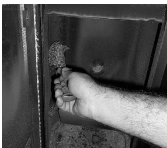
Figura 50 - Limpeza do interior da salamandra a água
