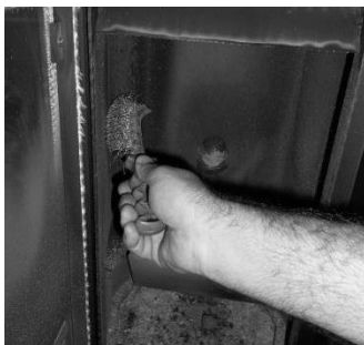
Figura 47 - Limpeza do interior da salamandra a água
