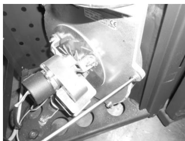
Figura 126 - a) Retirar os parafusos; b) Retirar extrator
