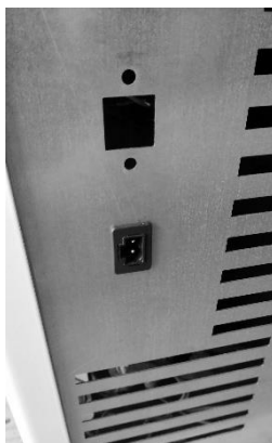
Figura 133 - Instalação do cronotermostato
