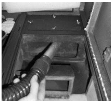
Figura 118 - Limpeza do interior da salamandra
